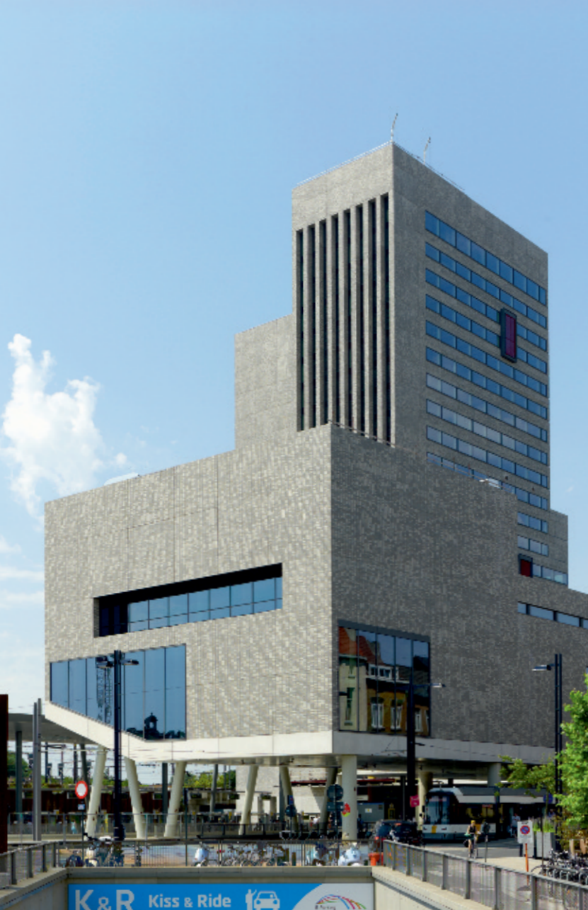
Bürokomplex in Gent (B)
