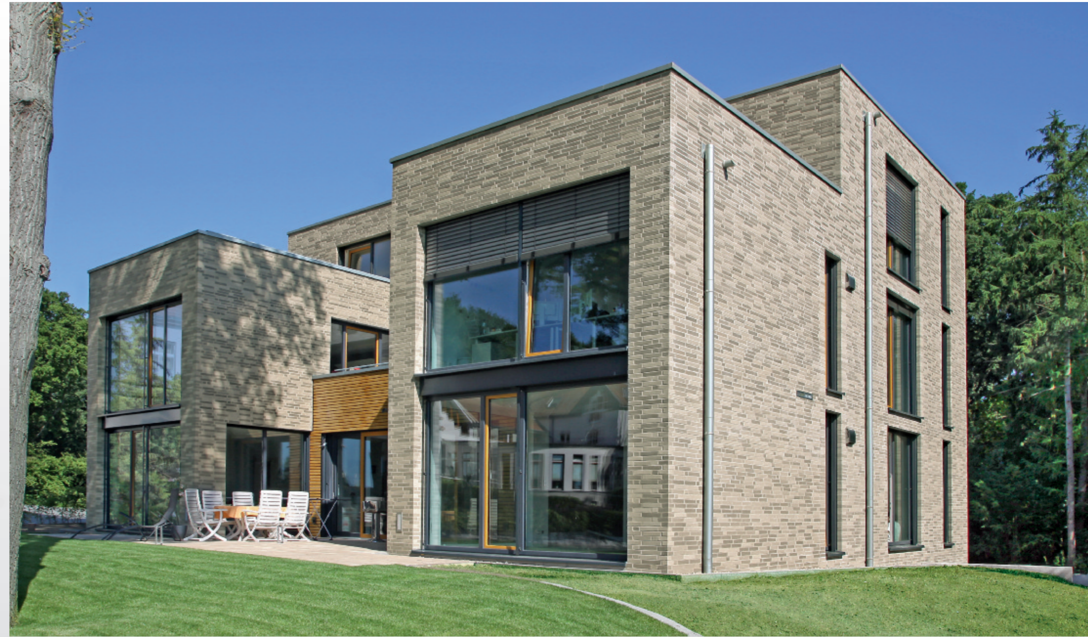
Wohn- und Bürogebäude in Schüttorf Planung: schröderwenning architekten, Schüttorf
