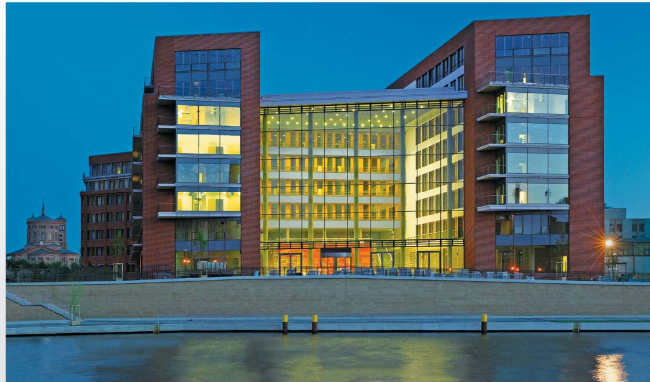
Bürogebäude „Spreeport“ in Berlin: Stürze und Balkone als Ziegel-Fertigteile, Röben Sonder-Formsteine für nicht rechteckige Gebäudeecken.
