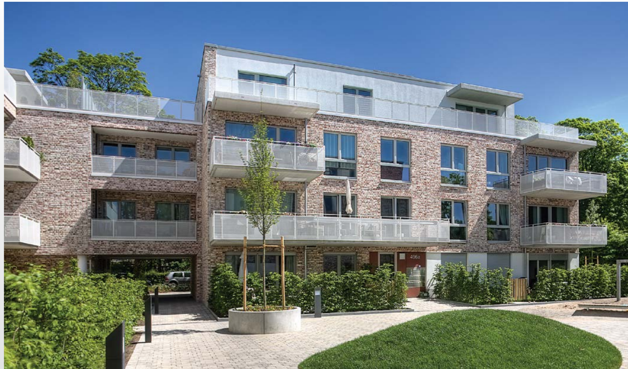
Wohnanlage in Hamburg Planung: kbnk Architekten, Hamburg
