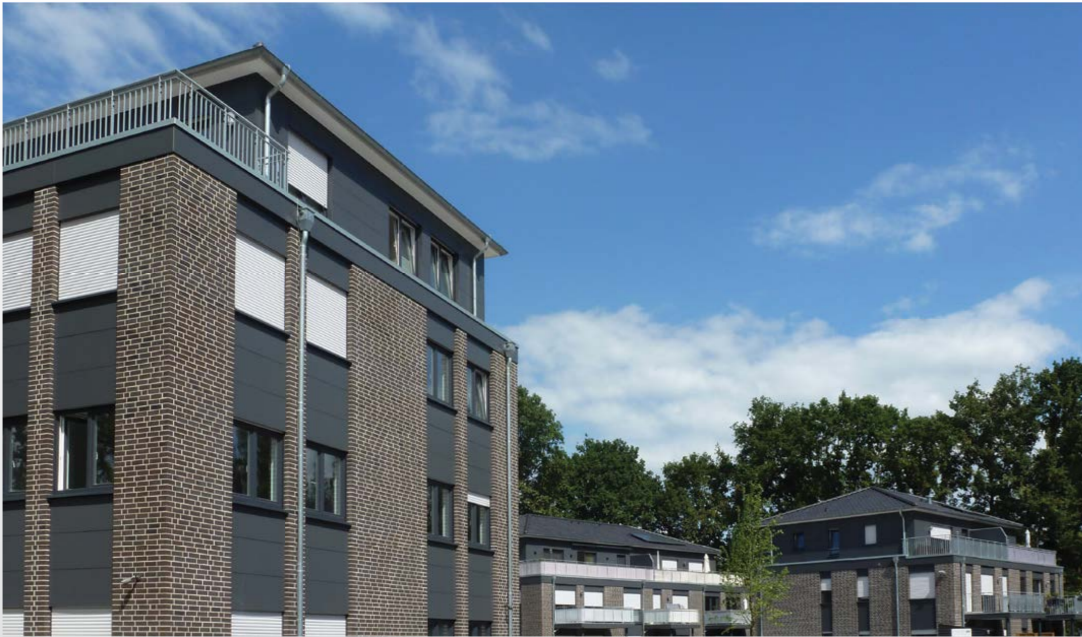
Wohn- und Bürokomplex, Oldenburg Planung: Torsten Jansen Architekturbüro, Berumbur
