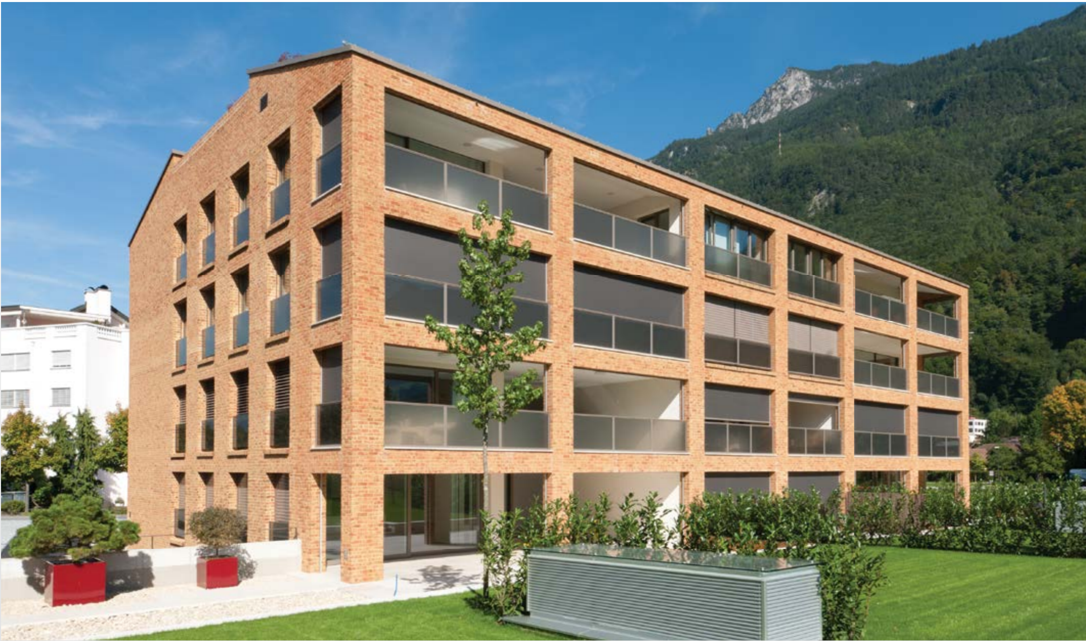
Mehrfamilienhaus in Vaduz (FL) Planung: Verling & Partner.Architekten, Vaduz (FL)
