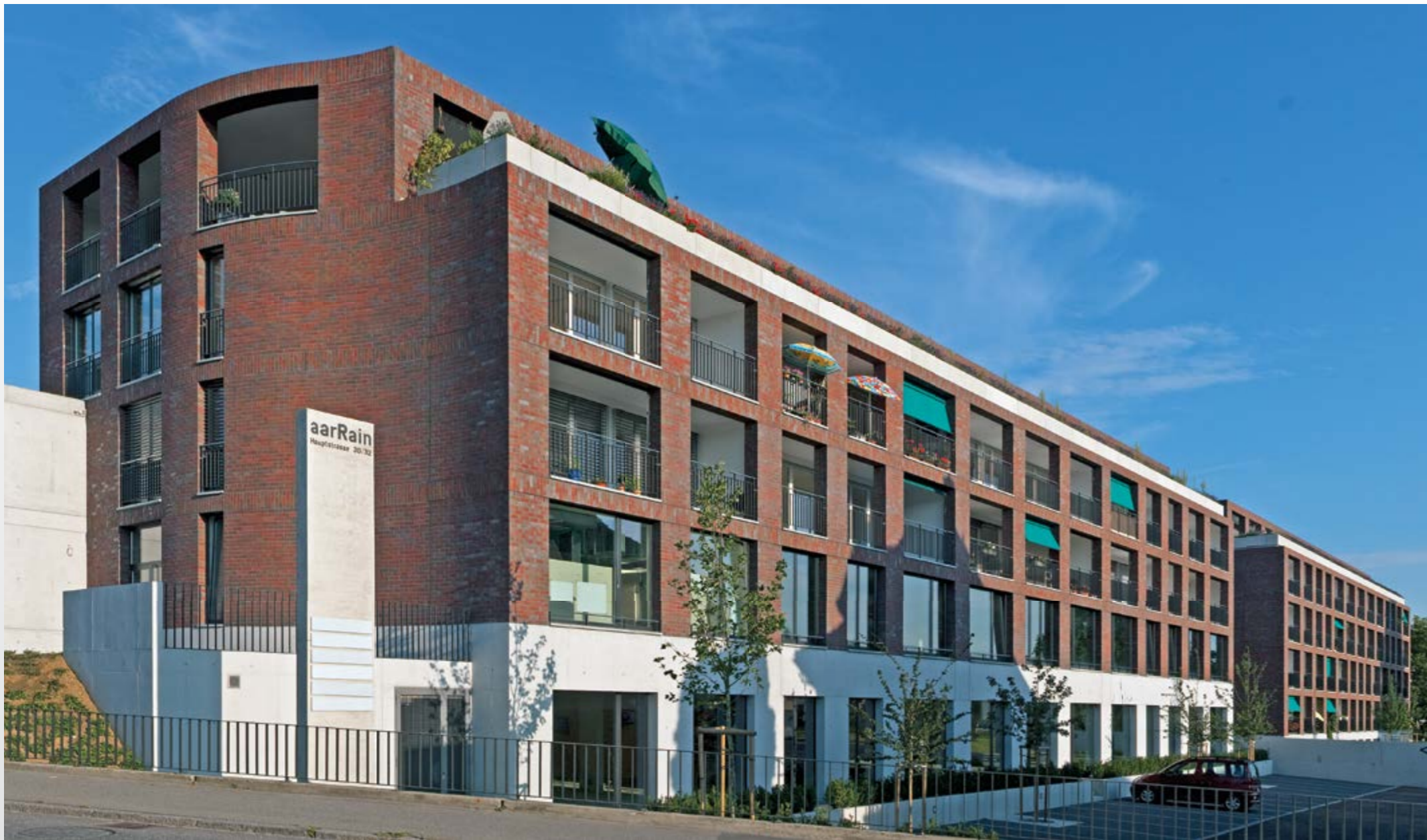
Wohnanlage in Döttingen (CH)
